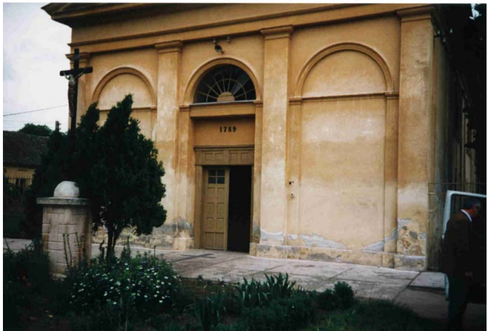
Abb. 92: Lowrin. Römisch-katholische Pfarrkirche „Hl. Peter und Paul“. 1785-1789. Westfassade, Detail.
