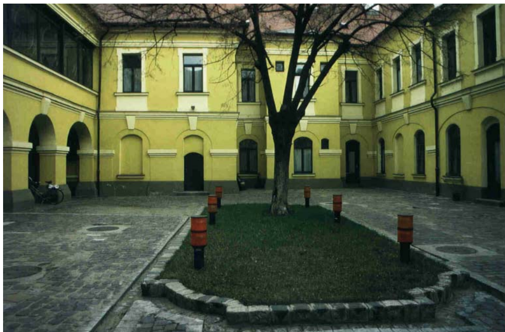
Abb. 22: Temeswar, Palais des römisch-katholischen Bischofs. 1743-1752. 1781-1786. Detail, Innenhof.
