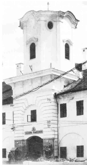
Abb. 10: Siebenbürger Kaserne 1719-1729. Detail, Turm.
