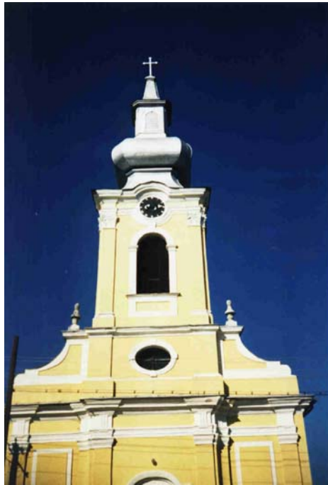
Abb. 108: Perjamosch. Römisch-katholische Pfarrkirche „Hl. Johann von Nepomuk“. 1772-1773. Westfassade, Detail.
