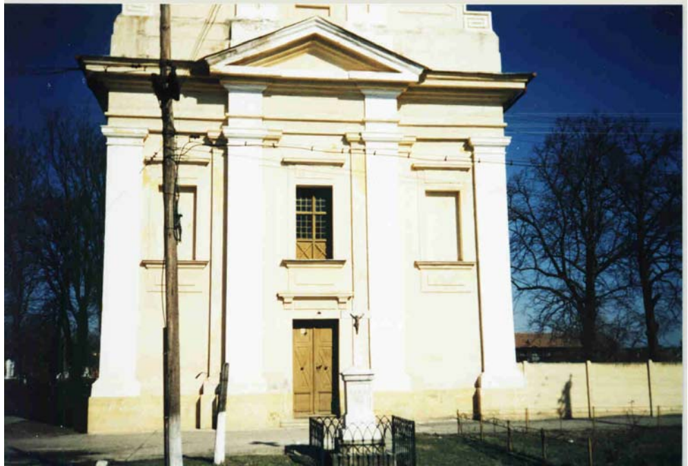
Abb. 156: Warjasch. Römisch-katholische Pfarrkirche „Hl. König Ladislaus“. 1821. Westfassade, Detail.
