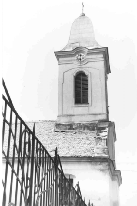
Abb. 85: Grabatz. Römisch-katholische Pfarrkirche „Maria von der immerwährenden Hilfe“ . 1780. Außenfassade, Detail.
