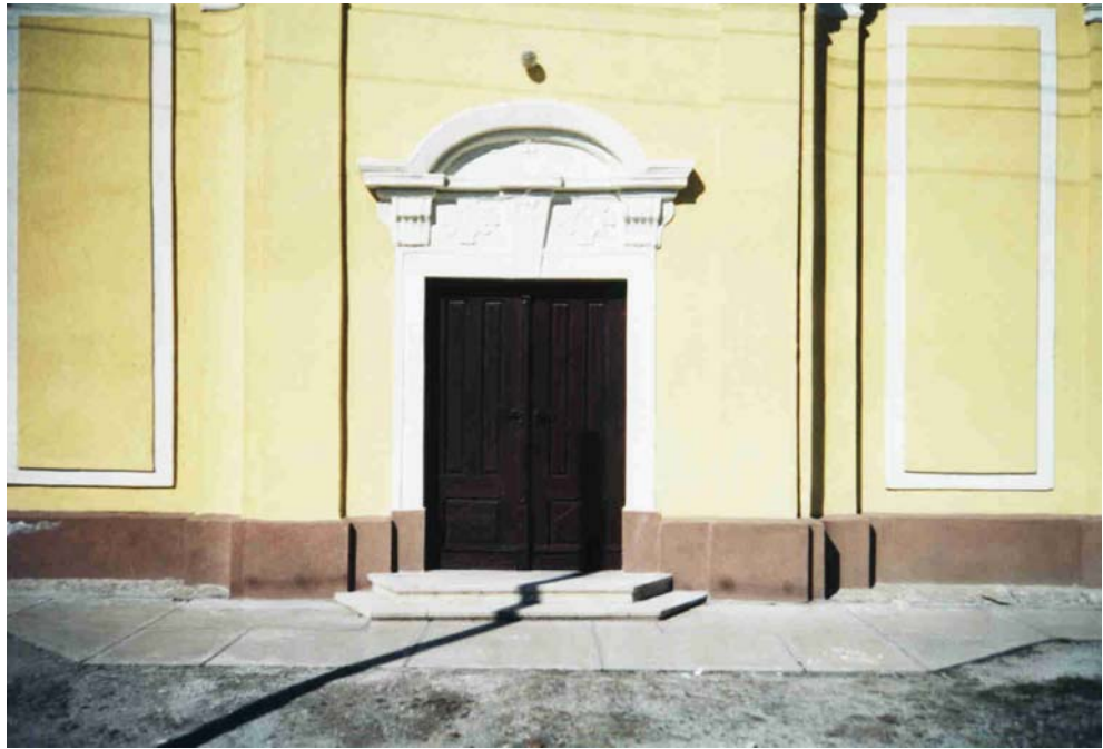
Abb. 110: Perjamosch. Römisch-katholische Pfarrkirche „Hl. Johann von Nepomuk“. 1772-1773. Westfassade, Detail.
