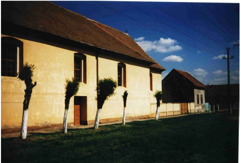
Abb. 112: Sackelhausen. Römisch-katholische Pfarrkirche „Hl. Erzengel Michael“. 1772-1773. Südfassade, Detail.
