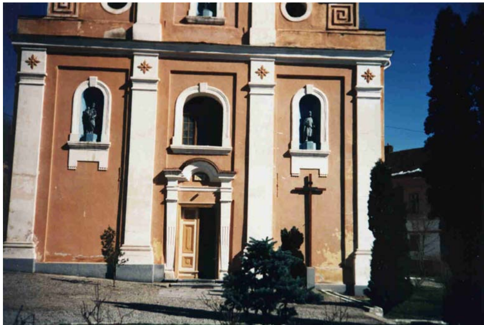
Abb. 33: Orawitz. Römisch-katholische Kirche „Hl. Kreuzerhöhung“. 1730-1754; 1772. Außenansicht, Detail.
