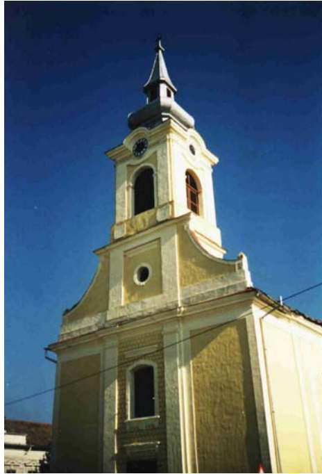
Abb. 115: Sanktandres. Römisch-katholische Pfarrkirche „Hl. Apostel Andreas“. 1753-1754; 1785; 1811. Westfassade, Detail.
