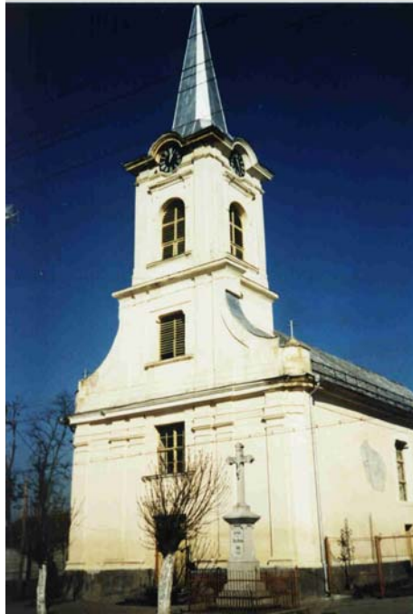
Abb. 98: Mercydorf. Römisch-katholische Pfarrkirche „Hl. Kreuzerhöhung“. 1788. Südfassade.
