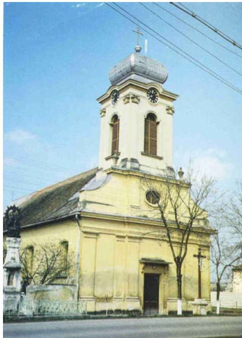
Abb. 72: Bruckenuau. Römisch-katholische Pfarrkirche „Hl. Dreifaltigkeit“. 1775-1776.
