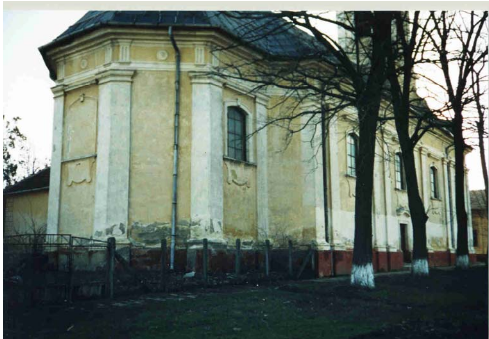
Abb. 135: Kleinbetschkerek. Römisch-katholische Pfarrkirche „Unbefleckte Empfängnis Mariens“. 1810-1811. Ostfassade.
