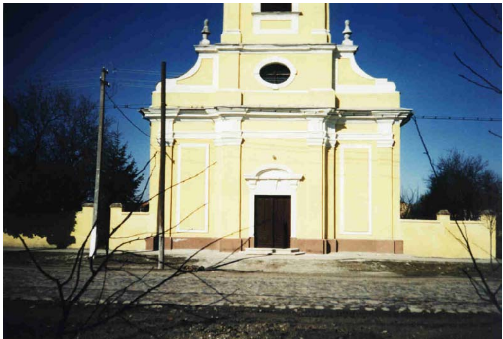
Abb. 109: Perjamosch. Römisch-katholische Pfarrkirche „Hl. Johann von Nepomuk“. 1772-1773. Westfassade, Detail.
