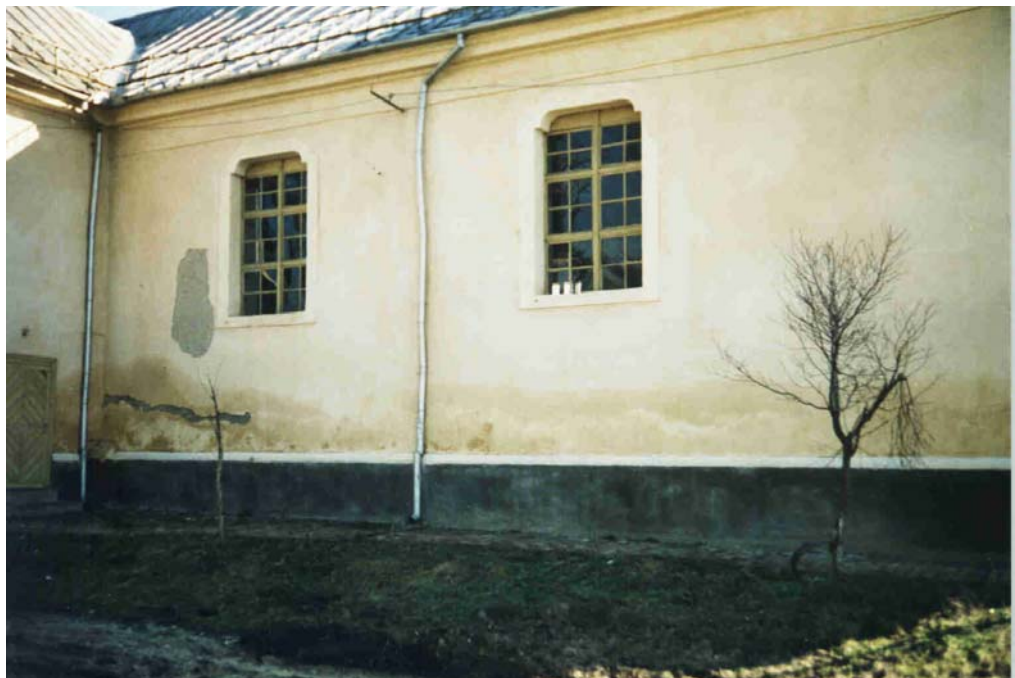
Abb. 116: Sanktandres. Römisch-katholische Pfarrkirche „Hl. Apostel Andreas“. 1753-1754; 1785; 1811. Südfassade, Detail.
