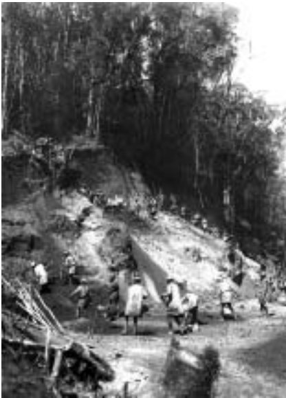
Photo 4 : Route de l'Est, un chantier en forêt
