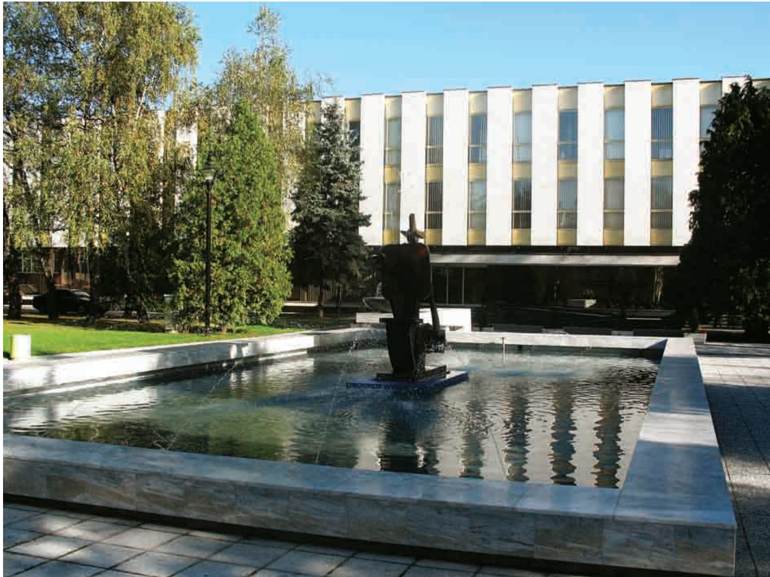
Зграда Народне скупштине Републике Српске • Building of the National Assembly of the Republic of Srpska
