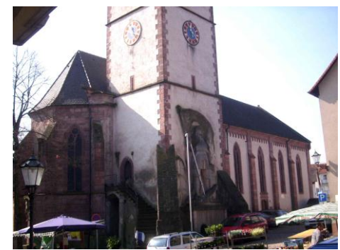
Der Turm entstammt der frühen gotischen Zeit, ist durch Schlitzscharten charakterisiert und wird von zwei imposanten Strebe Pfeilern stabilisiert.
