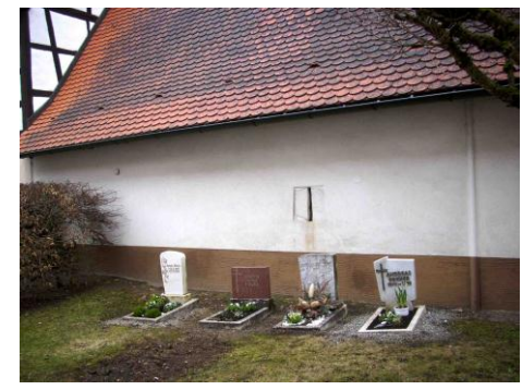
Im Jahre 1722 wurde das Pfarrhaus neu aufgeführt, die Mantelmauer als Außenwand nutzend. Und bei genauem Hinsehen finden sich noch sichtig belassene Schießscharten.
