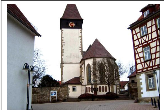
Der massive Turm hat heute keine „sichtigen“ Schußscharten mehr aufzuweisen. Sie liegen nach jüngster Restaurierung „unter Putz“.
