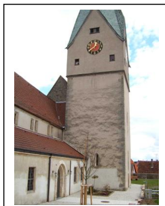
Schon im Jahre 1856 wird weidlich über die Entstellungen der romanischen Bausubstanz „gewettert“.
