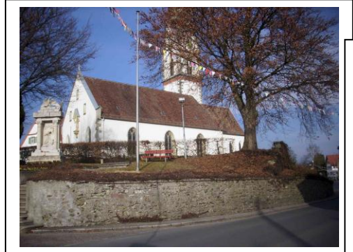
Ortsseitige Ansicht der „zu ebener“ Erde gelegenen Anlage mit dem Rest der hier in der Gründung als Futtermauer ausgeführten Mantelmauer.
