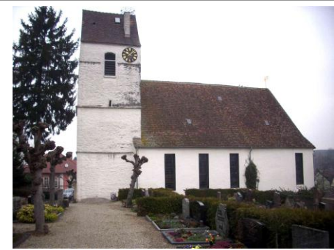
Der massive Turm der „Übergangszeit“, zu 3 Geschossen mit Schlitzscharten und Satteldach
