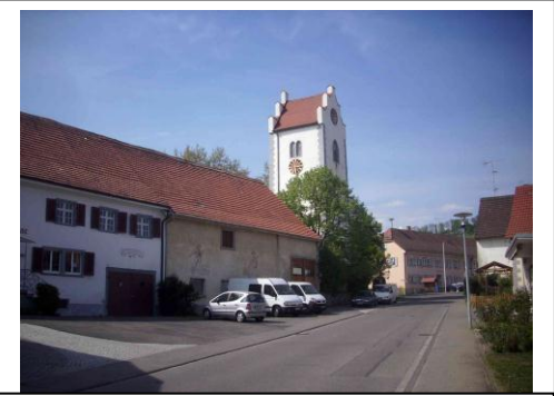
Einzig der Turm mit seinem Satteldach und den charakteristischen Staffelgiebeln zeigt den Standort der einst frei stehenden Anlage.
