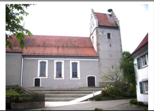
In einheitlichen Grau sieht der Besucher die hervortretende Stylosigkeit des völlig überformten Langhauses. Noch immer beherrscht der massive Turm das Bild.
