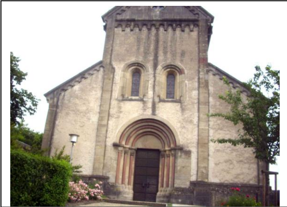
Bild A: Ansicht von Westen, Giebelseite des Langhauses mit dem Hauptportal.
