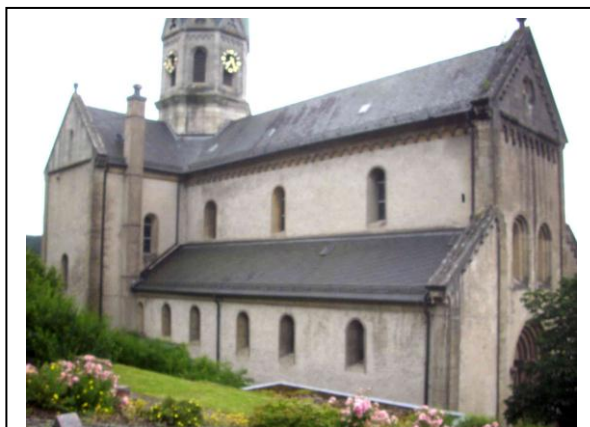
Bild D: Ansicht von Nordwesten mit dem Vierungsturm und nördlichem Querhausarm.
