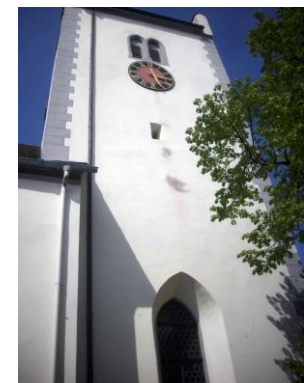
Der massive Turm ist als Chorturm gegründet und mit Schlüsseloch-Scharten im mittleren Geschoß ausgestattet.
