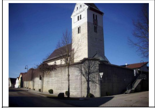
Man mag sich seinen Teil dazu denken – kosteneffizienter war es in jedem Fall, die alte Mantelmauer durch Beton zu imitieren.
