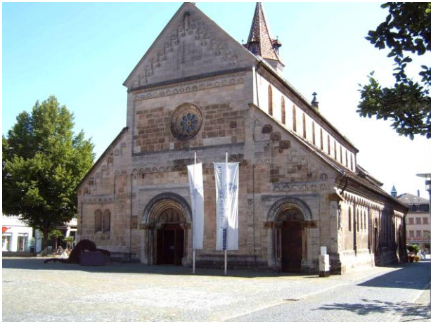
Bild A: Ansicht von Westsüdwest; Fokus auf der Giebelseite
