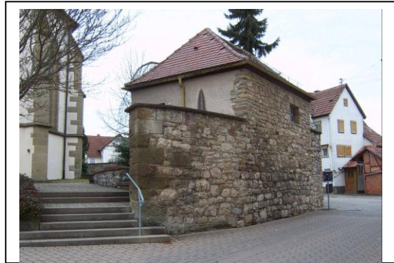
Geringer Rest der Mantelmauer, die ab 1836, beginnend mit dem hier stehenden Tortuem, schrittweise abgebrochen wurde.
