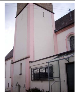
Der aus gotischer Zeit heraufreichende Turmkern ist in den mittleren Geschossen mit Schlitzscharten ausgestattet. Die Basis offenbart seine Gründung als Chorturm.
