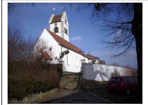
Talseitige Ansicht mit der bis auf den Umgang erhaltenen Mantelmauer.
