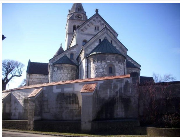
Bild C: Ansicht von Osten mit der unterteilten Struktur in diesem Bereich.
