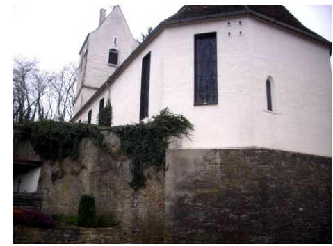
Etwas „alte Bausubstanz“ finde sich in der Westseite des neuen Langhauses in Form der früheren Futtermauer.
