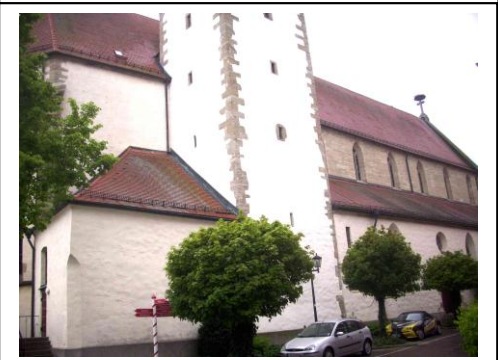
Die nähere Betrachtung des Turmes zeigt eine Eckquaderung, die zusammen mit den Biforien der Glockenstube sein hohes Alter ausweist. Das Langhaus ist heutzutage leider der Stylosigkeit anheimgefallen.
