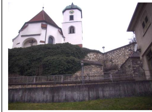
Von der Ortsseite gesehen, ist der Eindruck auch heute noch „martialisch“. Die noch rund 2/3 hohe Mantelmauer entstammt mindestens dem 14. Jhd.
