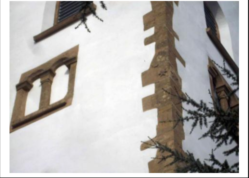
Von innen vermauerte Biforien und besondere Figurenreliefs an den Eckquadern in Höhe der Biforien charakterisieren den Turm.
