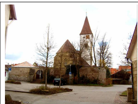
Interessanterweise wird die Mantelmauer in der Beschreibung von 1856 nicht erwähnt – aber sie ist da.
