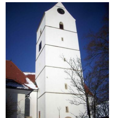
Einheitlich mit Schlitzscharten in 4 Geschossen ausgestattet, „rüstete“ man im dritten zu gotischer Zeit mit Schlüsselloch-Scharten nach. Die Glockenstube ist aus dem 18. Jhd.
