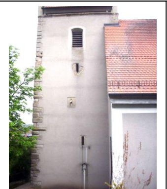
Sein hohes Alter weist der Turm unter anderem durch seine Eckquaderung mit Bossensteinen (Buckelquader) aus, weshalb man auch schlicht aber treffend von „Bossierung“ spricht.
