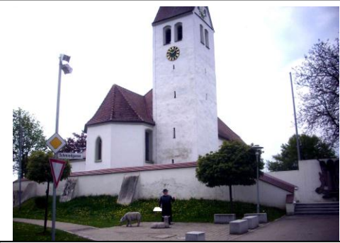
Ortsseitige Ansicht mit der Mantelmauer in Resten. Zur Rechten ist der Platz der ehemaligen Toranlage. Die Glockenstube des Turmes entstammt dem 18. Jhd., in ihrer heutigen Form.
