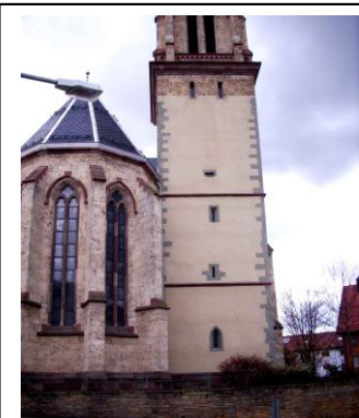
Sieht man sich den Turm genauer an, dann bemerkt man im mittleren Geschoß „Hackenscharten“, welche zu spätgotischer Zeit für Feuerwaffen nachgerüstet wurden.
