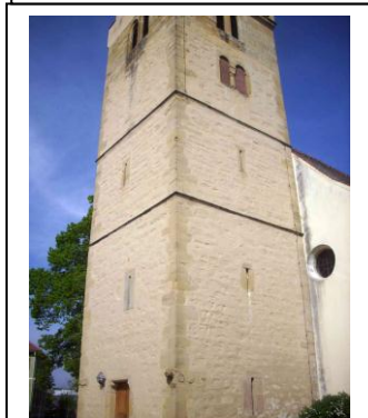
Dem Turm ließ man im 19. Jhd. Einen neuen Eingang angeheihen, aber die Schlitzscharten sowie die Biforien entstammen der Gründungszeit
