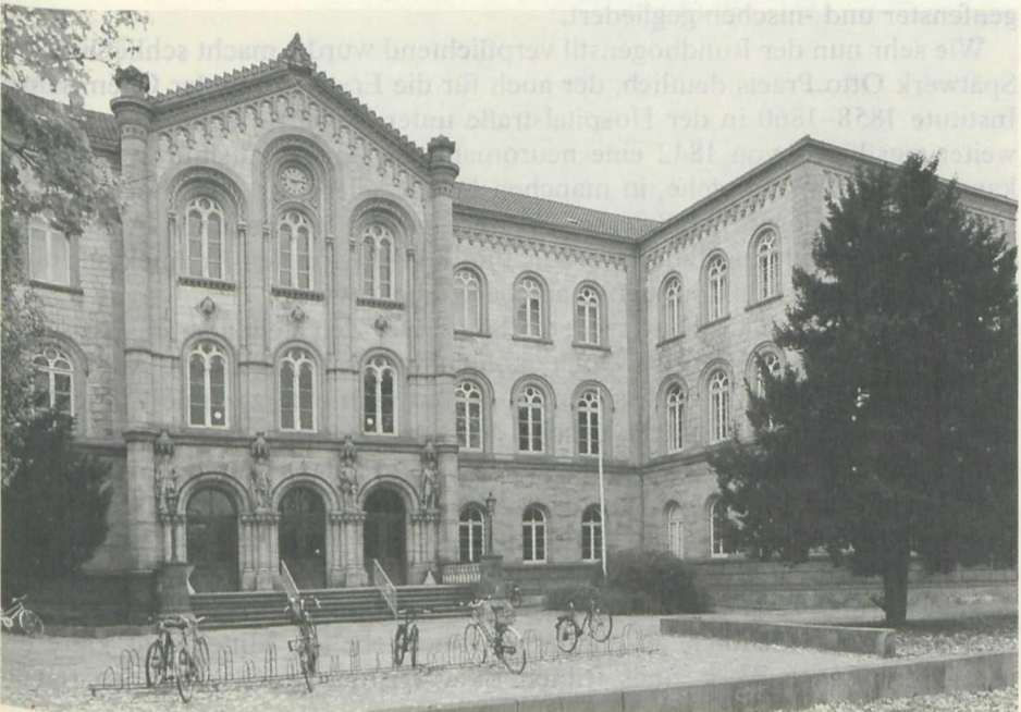
Abbildung 28: Friedrich Doeltz, Auditorium, Zustand 2001 (Foto: Christian Freigang).
