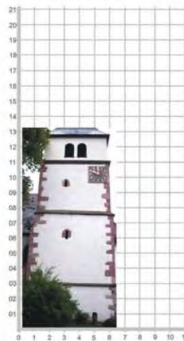
Anlage: Neuneck Kreis: Freudenstadt Außenmaß: 6,2 * 3,3 Meter Anmerkung: S-Scharten
