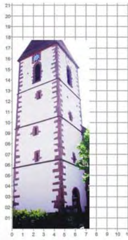
Anlage: Erbhausen Kreis: Calw Außenmaß: 7,3 Meter Anmerkung: S-Scharten
