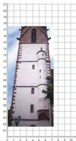
Anlage: Donstetten Kreis: Freudenstadt Außenmaß: 7,2 Meter Anmerkung: S-Scharten
