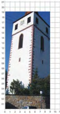
Anlage: Altingen Kreis: Tübingen Außenmaß: 9 Meter Anmerkung: SLS-Scharten
