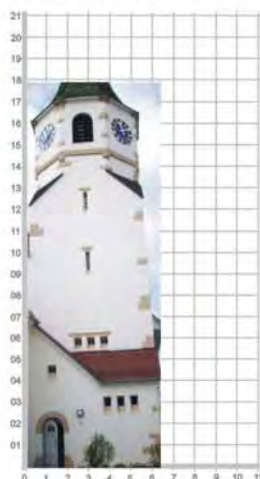
Anlage: Nötzingen Kreis: Esslingen Außenmaß: 6,3 Meter Anmerkung: S-Scharten
