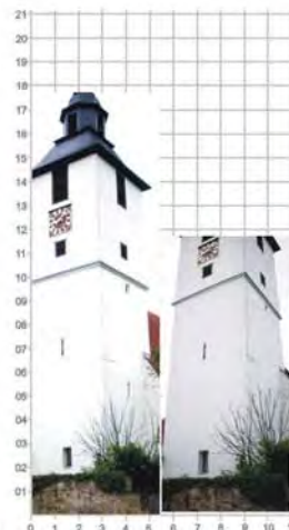
Anlage: Uhingen Kreis: Göppingen Außenmaß: 5,4 Meter Anmerkung: SLS-Scharten
