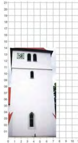
Anlage: Salach Kreis: Göppingen Außenmaß: 7,4 Meter Anmerkung: S-Scharten
