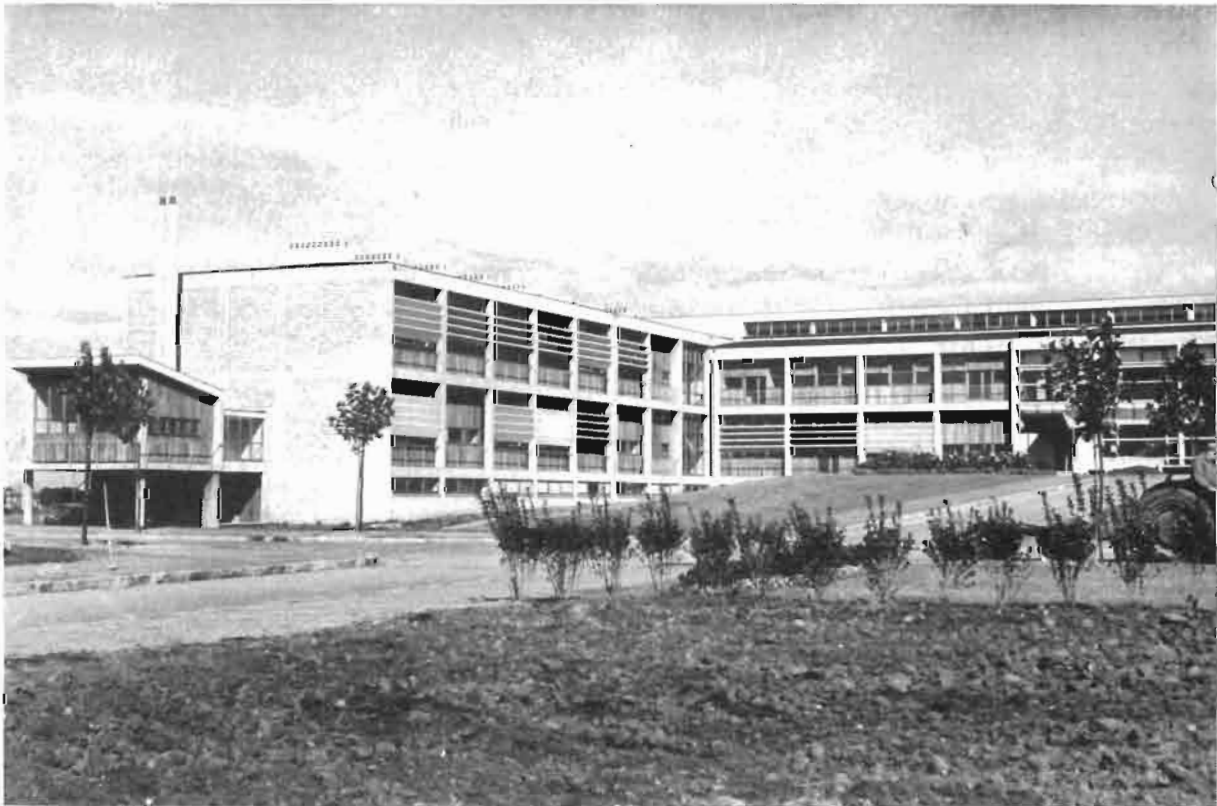
Institut d'Enseignement et de Recherches Tropicales de Bondy — Vue du bâtiment des laboratoires
