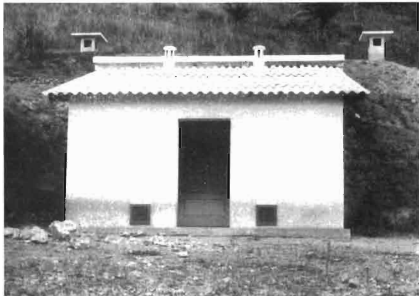
Institut d'Études Centrafricaines Station géophysique de Bangui (A. E. F.) -- Vue de la cave magnétique à demi enterrée {on distingue au fond les cheminées d'aération}
