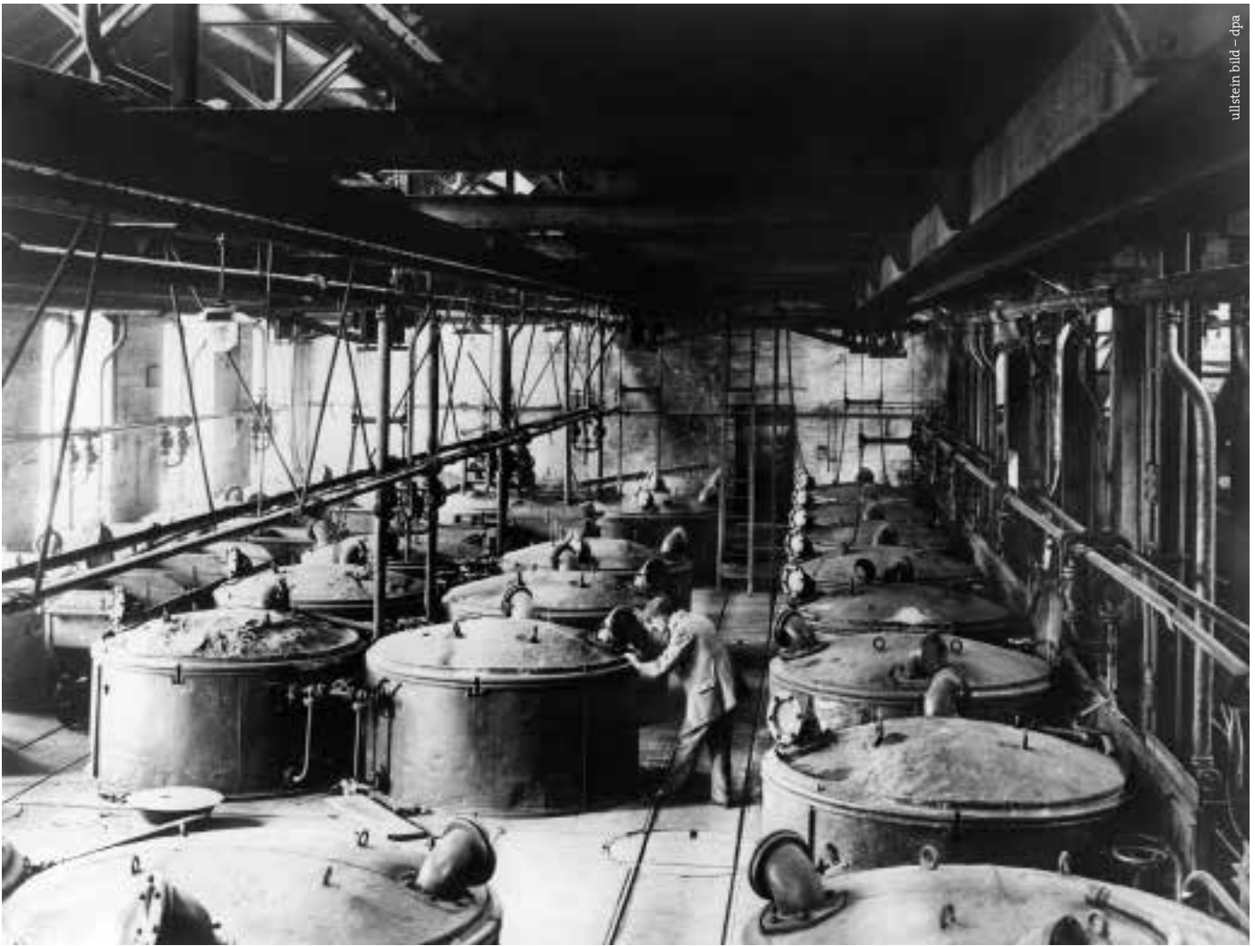
... Herstellung von synthetischem Indigo an dem 1865 in Ludwigshafen gegründeten Produktionsstandort der BASF (ehemals Badische Anilin- & Soda-Fabrik). Durch Schaugläser kann der Prozessablauf beobachtet werden.
