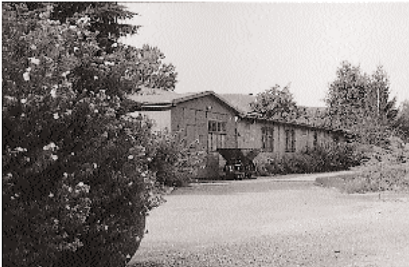
Eine der erhalten gebliebenen ehemaligen Häftlingsbaracken des KZ-Außenlagers Wernigerode, Veckenstedter Weg. Die Gefangenen mußten für die Rüstungsfirma »Rautalwerke GmbH« arbeiten.
