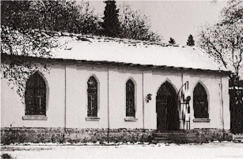
Plauen: Feierhalle auf dem Jüdischen Friedhof am Oberjößnitzer Weg. Sie wurde 1987/88 umgestaltet zur Gedenkstätte, in der Tafeln und Dokumente über die Geschichte der Juden in Plauen und in der Region informieren.
