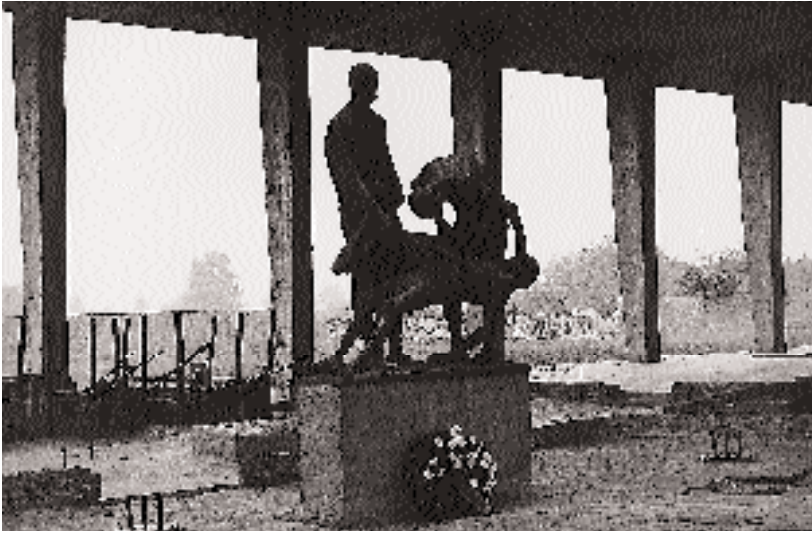
Ehemalige Krematoriums- und Erschießungsstätte »Station Z« in Sachsenhausen mit der Skulpturengruppe von Waldemar Grzimek, seit 1990 zentraler Gedenkort. Die Neugestaltung sieht einen Abriß der Dach- und Stützenkonstruktion und eine neue bauliche Hülle vor.
