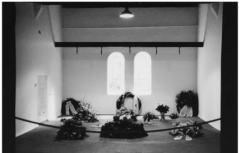
Gedenkraum in der ehemaligen Richtstätte des Zuchthauses mit den historischen Haken für Hinrichtungen durch den Strang.
