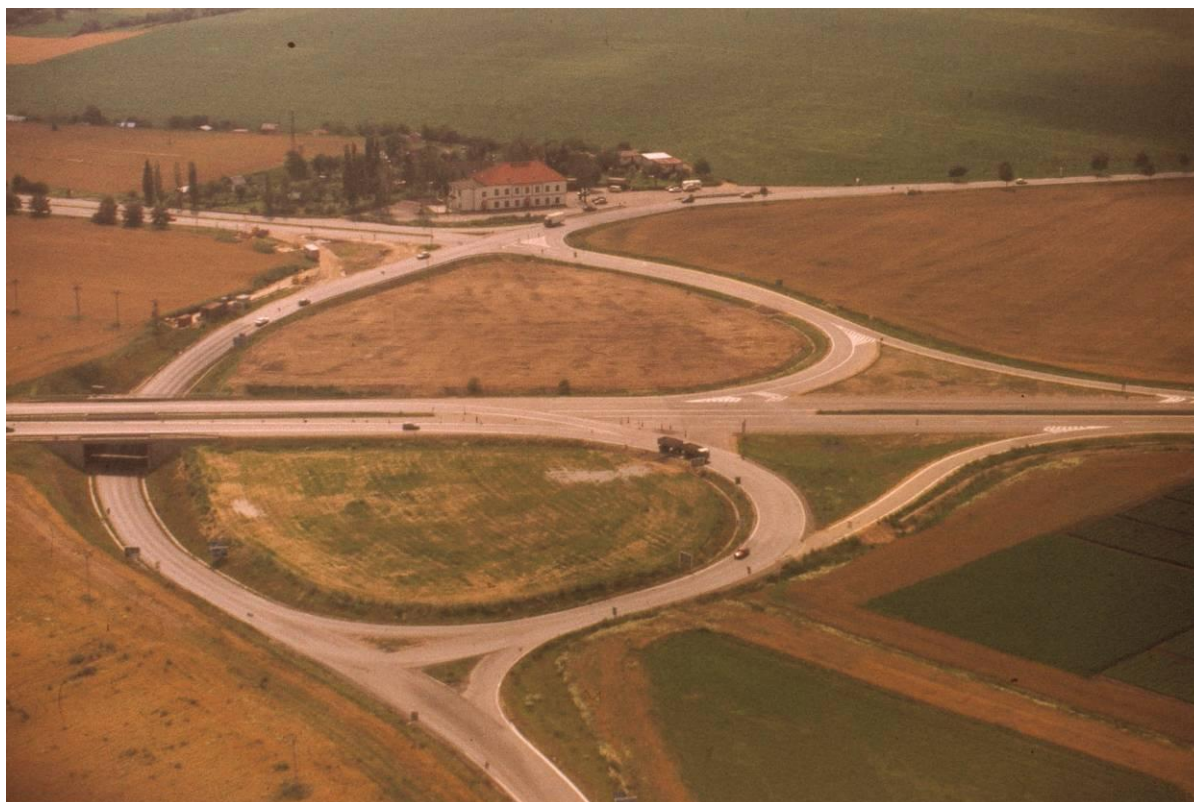
Křižovatka Zdiby – vlevo přichází Prosecká radiála, vpravo pokračuje trasa k dálnici D 8, která začíná přibližně 400 m od této křižovatky. Dole navazuje silnice I/9, vlevo nahoře je původní čtyřpruhový výpad z Prahy, vpravo nahoře původní silnice I/8, dnešní II/608. Na křižovatce je původní hostinec Na Staré poště.
