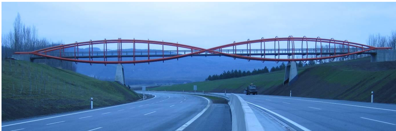
Lávka pro pěší na dálnici D 8 v úseku Trmice–státní hranice
