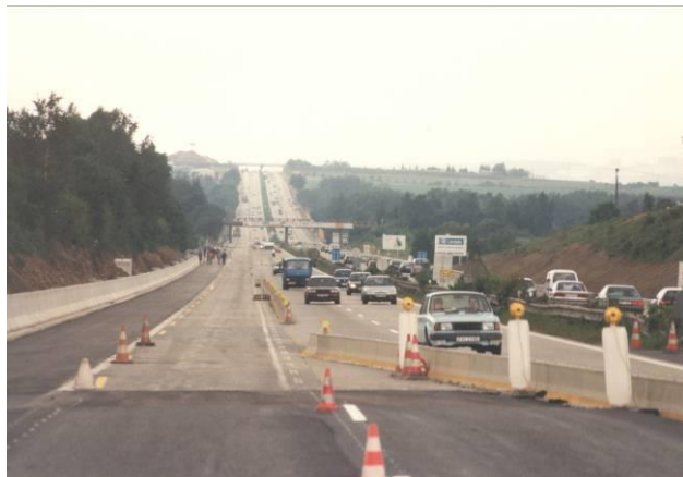
Ocelové vodící stěny uložené na SSÚD Mirošovice a umístěné na trase dálnice
