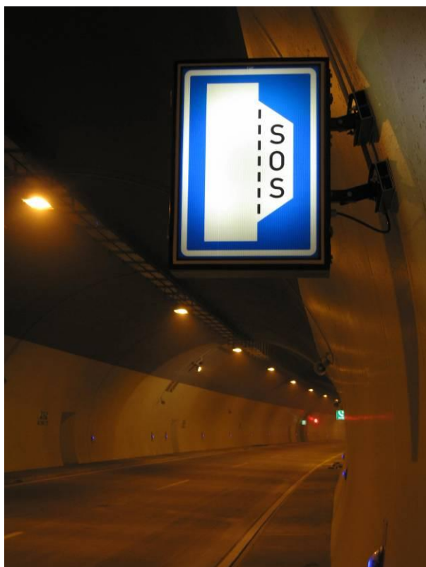
Označení nouzového zálivu a úniková propojka mezi tunelovými troubami v tunelu Panenská, vlevo jsou dveře do rozvodny
