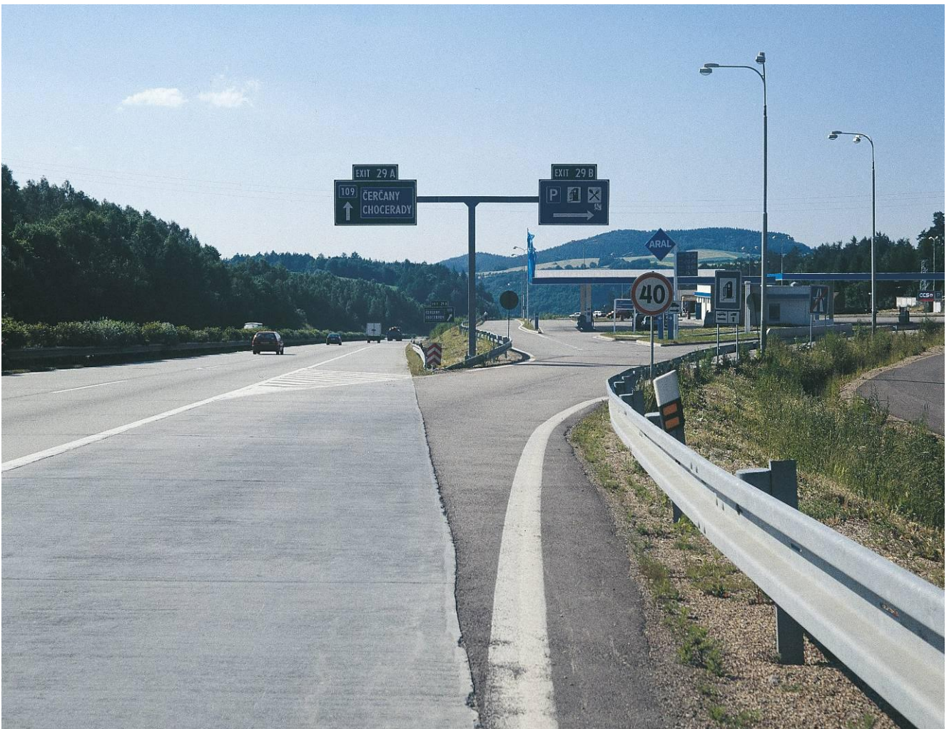
První portálová konstrukce na D 1 byla osazena na odpočívce Naháč u křižovatky Hvězdovice v roce 1992
