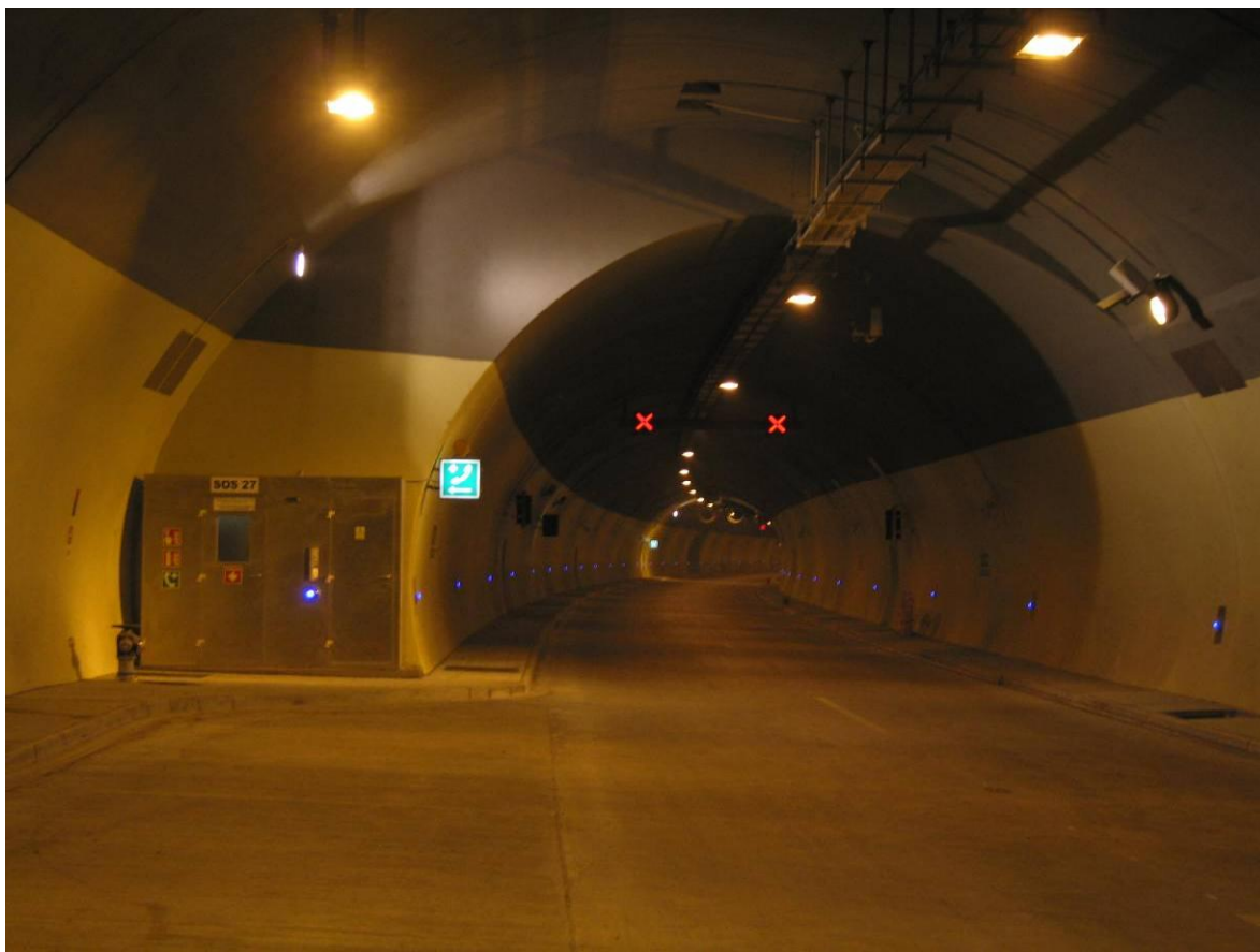
Nouzový záliv v levé troubě tunelu Panenská
