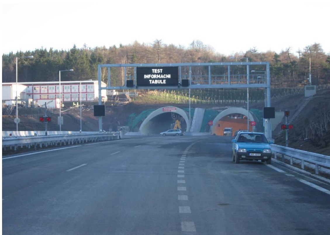
Severní portál tunelu Panenská 15. prosince 2006
