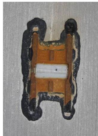
Zapuštěné dopravní knoflíky spolehlivě odolávají sněhovým radlicím při zimní údržbě. Na mostech se bílé knoflíky doplňují modrými pro upozornění na místo, které může v zimě namrznat.
