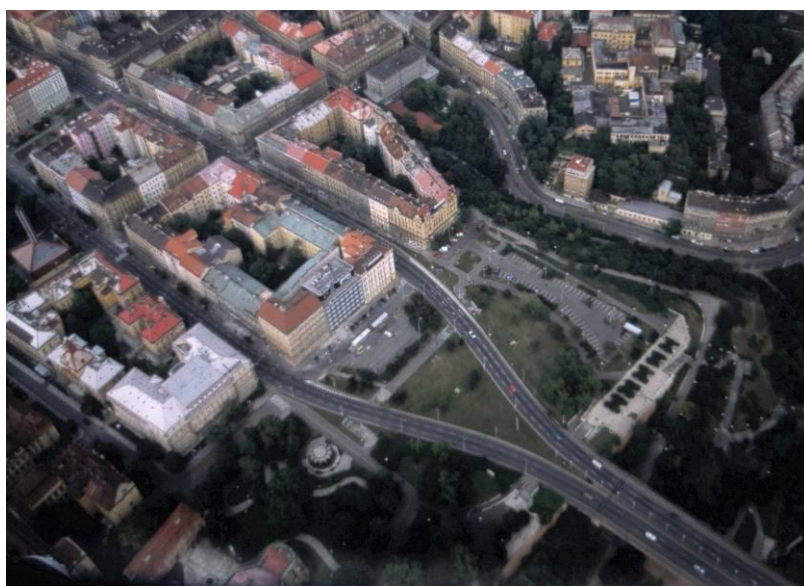
Zaústění II. SJM z Nuselského mostu na Karlově do ulic Sokolské a Legerovy si vynutilo demolici celého areálu dětské nemocnice
