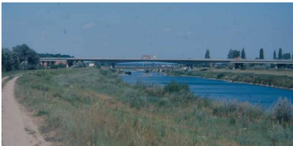
Most přes řeku Moravu při opravě v roce 1992
