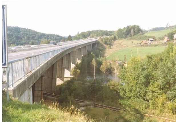
Most Hvězdovice, který je ve směrovém i výškovém oblouku, se stavěl letmou betonáží na výsuvné skruži
