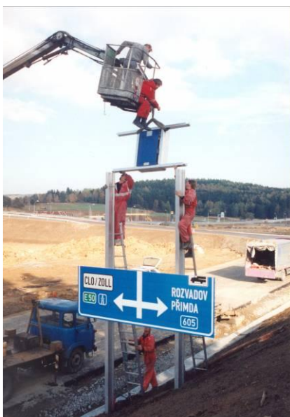
Montáž proměnných značek na křižovatce a odpočívce Kateřina
