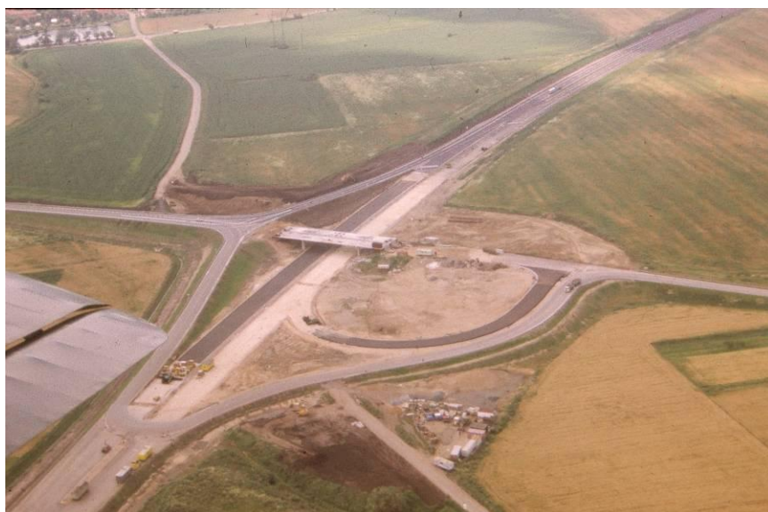
Křižovatka Úžice na D 8 ve stavbě
