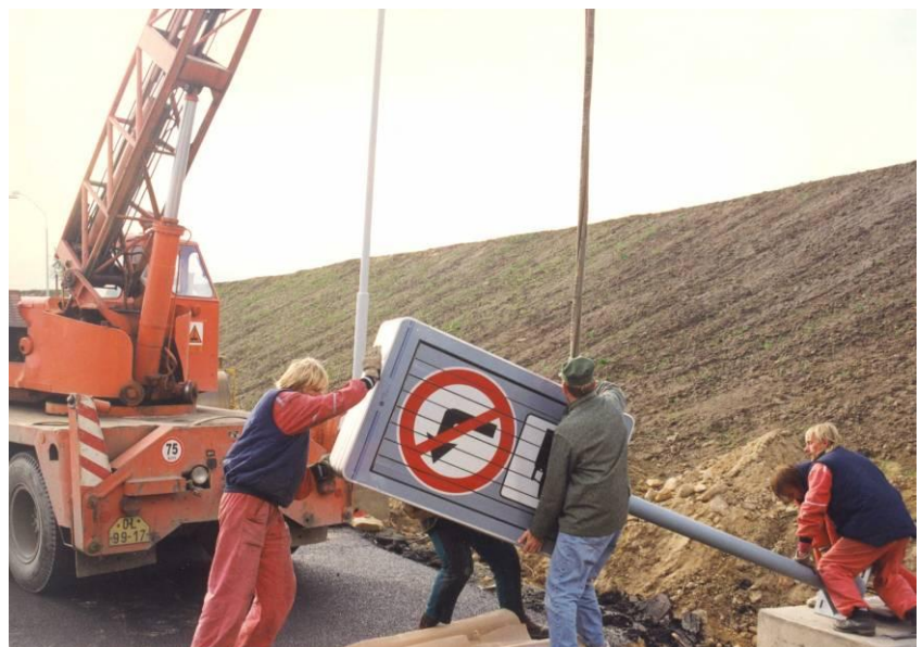
Montáž proměnných značek na křižovatce a odpočívce Kateřina
