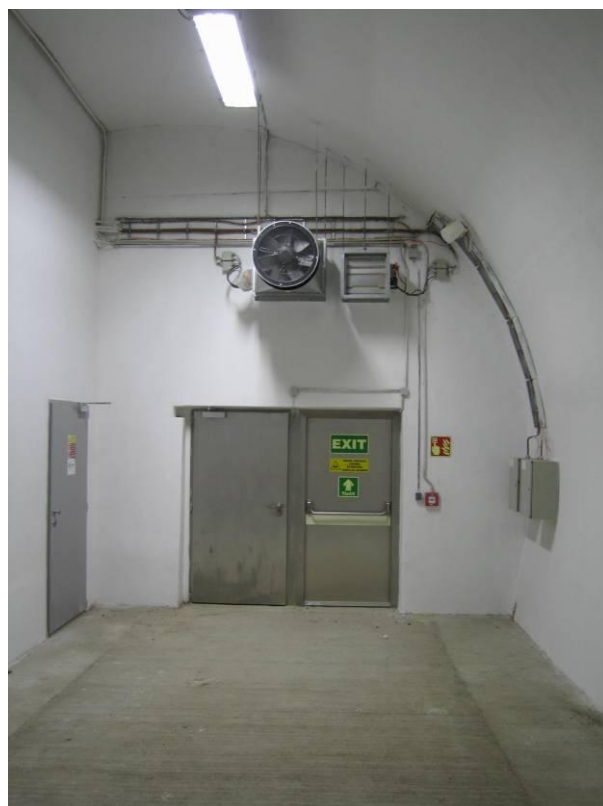
Označení nouzového zálivu a úniková propojka mezi tunelovými troubami v tunelu Panenská, vlevo jsou dveře do rozvodny
