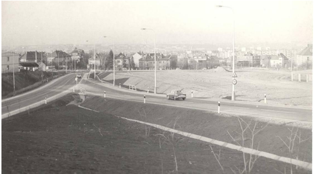
Takto vypadal nájezd na dálnici D 1 v km 0,0 dlouhou dobu. Dnešní podoba křižovatky s napojením Spořilovské spojky (v původních projektech III. stavba severojižní magistrály) od Bratislavského náměstí vznikala postupně v několika etapách (foto Pavel Havránek, 28. prosince 1972)
