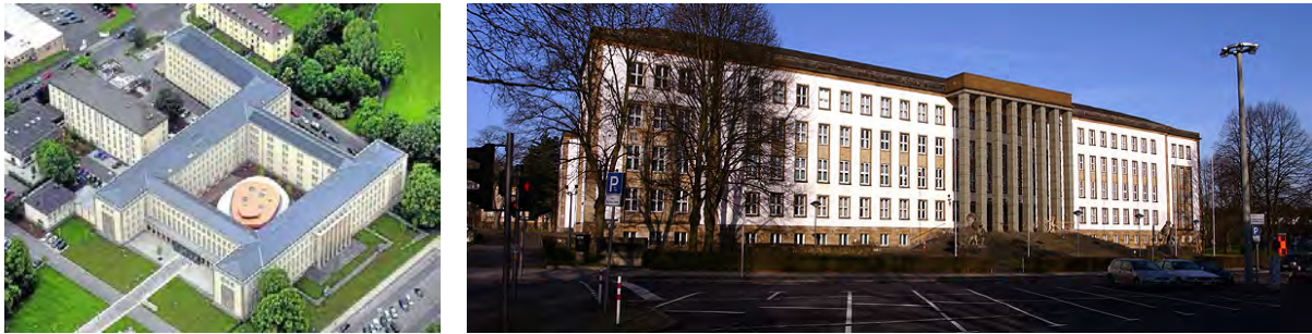
Ansichten des Bundessozialgerichts. Rechts: ehemaliger Eingang auf der Ostseite
