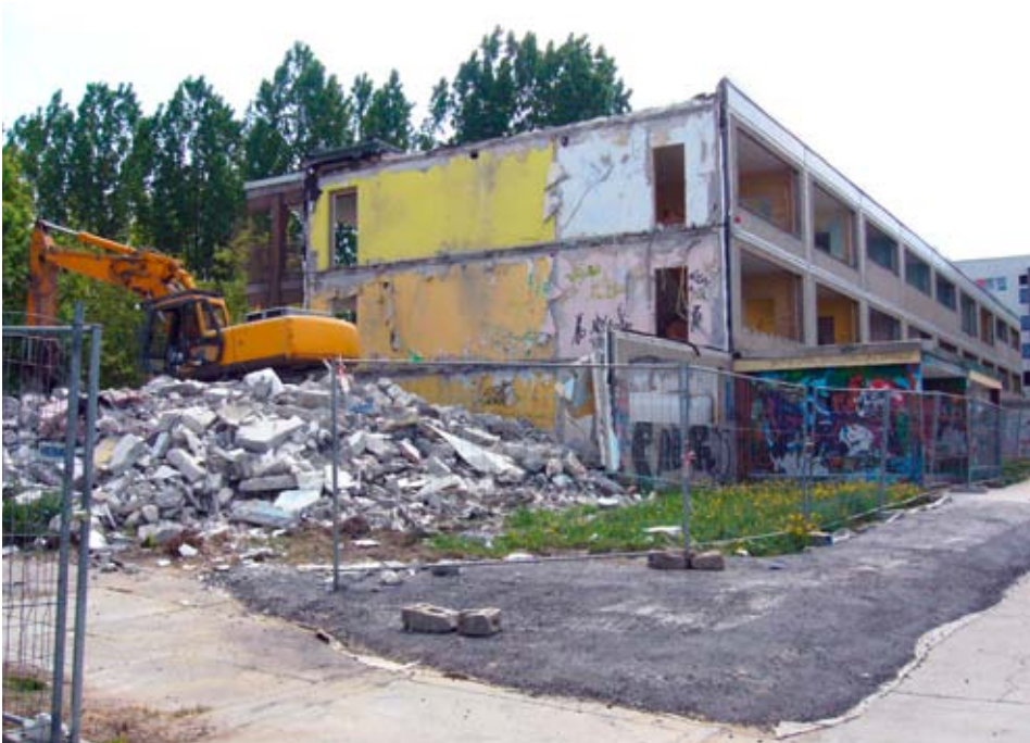
Abriß einer Kinderkombination in der Hellersdorfer Peter-Huchel-Straße 41/43 im Rahmen des Programms Stadtumbau Ost, 2006.
