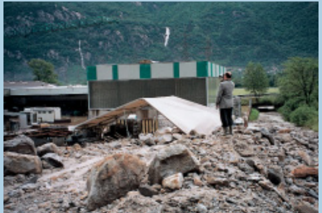
Räumung des Gerölls auf dem Gelände der Firma Genazzi & Artioli.
