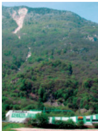
Felsbrocken und Geröll, die sich unterhalb der Alpe di Roscero lösen, rutschen in der Rinne des Riale Valegion auf die Gebäude der Firma Genazzi & Artioli zu.
