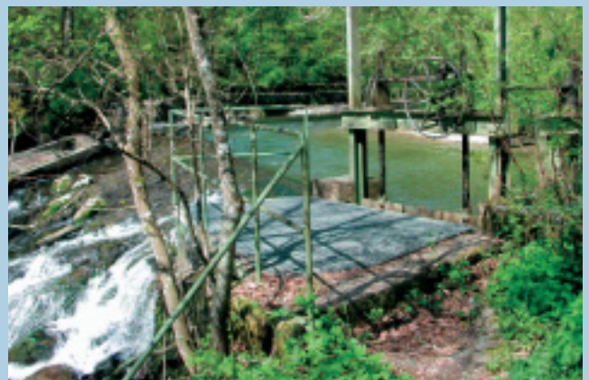
Hier zweigt der «Canal des Usiniers» von der Versoix ab. Der Wasserstand im Kanal wird von den Gewerbetreibenden mit Stauwehren reguliert.
