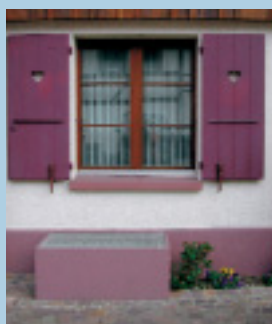
Hoch gesetzte Kellerschächte und niedrige Mauern hindern das Wasser daran, in den Keller zu fliessen.
