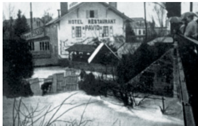
Im Jahr 1910 trat die Versoix zum letzten Mal über die Ufer. Zuschauer betrachten von der Brücke aus die Bescherung.
