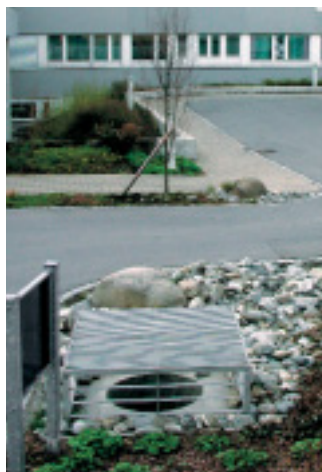
Niedrige Mauern und Einlaufschächte sichern das Spital vor einer neuerlichen Überflutung.
