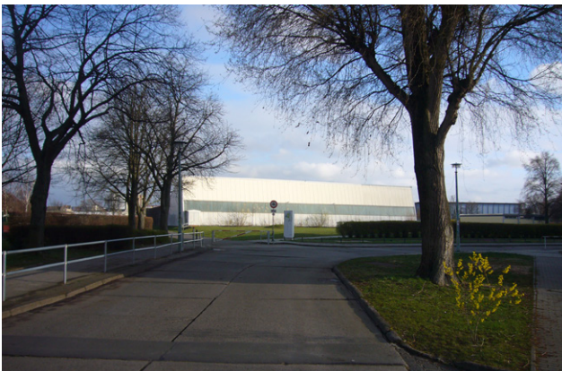
09) Blick von der Fritz-Lesch-Straße Richtung Süden
