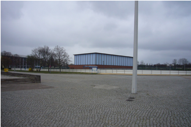
05) Blick von Süden auf die Beachvolleyballhalle
