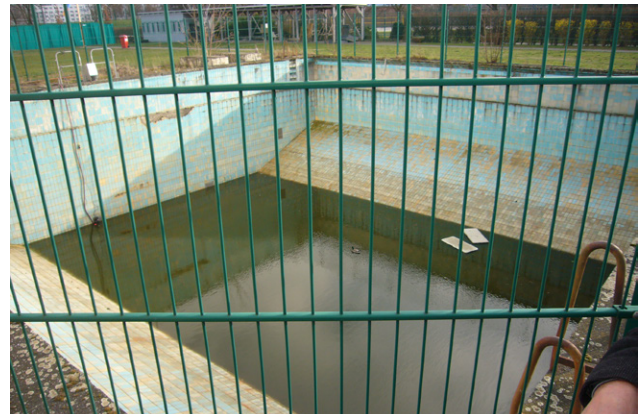
10) Regenrückhaltebecken an der Bogensportanlage
