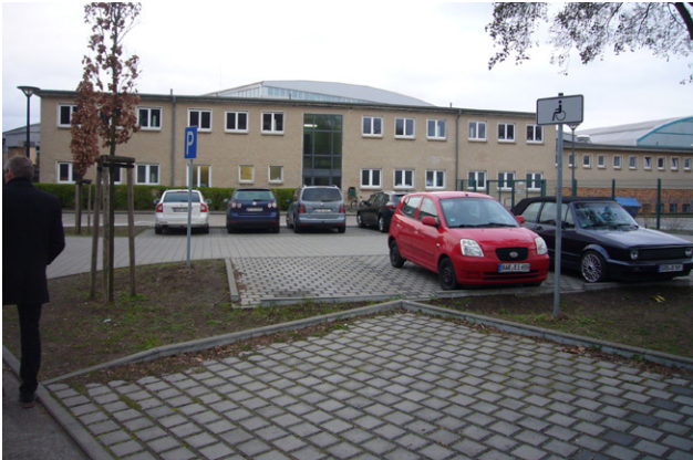
17) Blick von Nordosten auf die Umdkleiden der Eissporthalle
