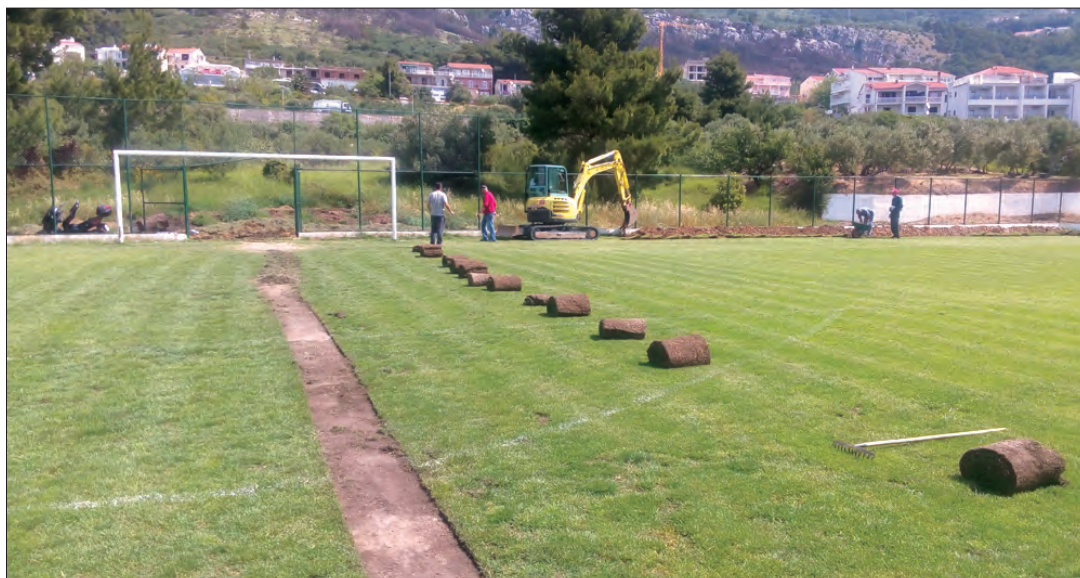
Radovi na ugradnji automatskog navodnjavanja
