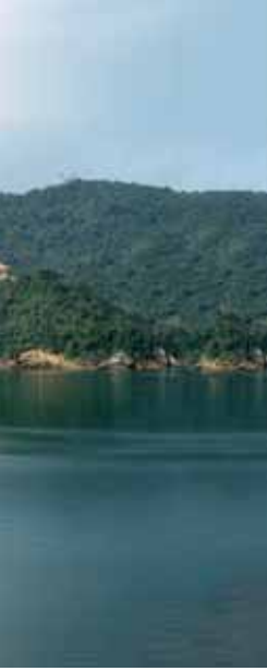
Guangzhou II (China): eines der größten Pump- speicherkraftwerke der Erde, ausgestattet mit Technik von Voith
