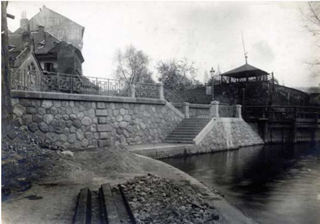
Úprava horního vtoku do Čertovky hned po dokončení v roce 1921. Za novostavbou kyklopských zdí ještě stojí altán na ohradní zdi Nosticovské zahrady, úplně vlevo štít hospodářského objektu, který stál před domem čp.446. Fotodokumentace ze stavebního deníku stavby, která trvala od roku 1909 do roku 1922
