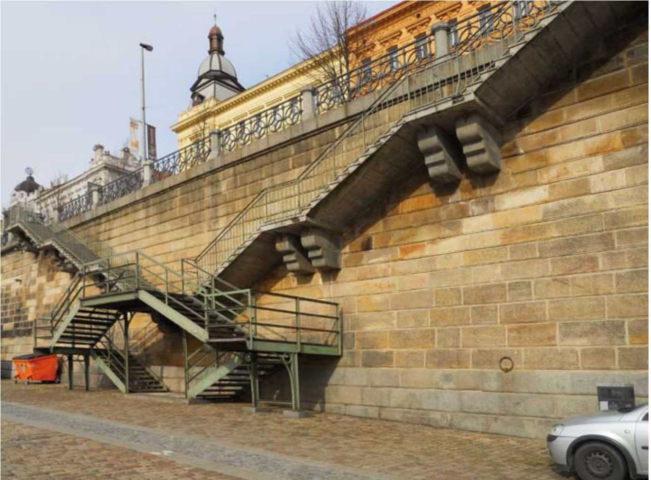
Schody vybudované dodatečně s výstavbou podběží severní části Palackého (dnes Rašínova) nábřeží kolem roku 1905. Dobře je zde patrný původní obklad z kamenných kvádrů, v dolní části žulový, v horní pískovcový.
