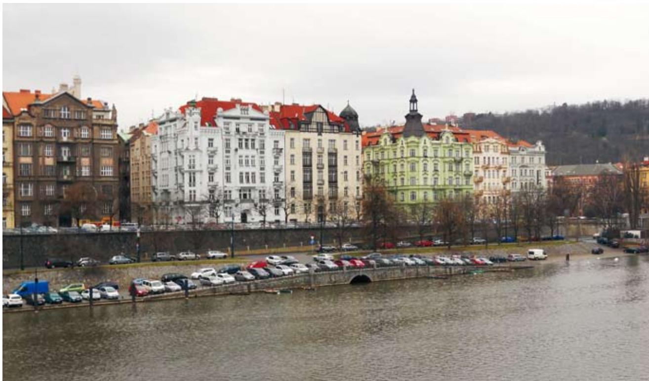
Na jižní části Janáčkova nábřeží se stále parkuje.
