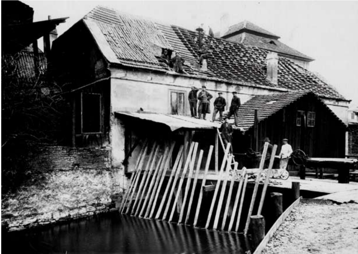
Oprava střechy na budově Hut'ského mlýna. Foto Antonín Alexandr, 1925, Klub Za starou Prahu
