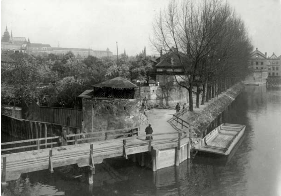
Dřevěný můstek přes vyústění Čertovky do Vltavy. Foto neznámého autora, kolem 1905. Muzeum hl. m. Prahy
