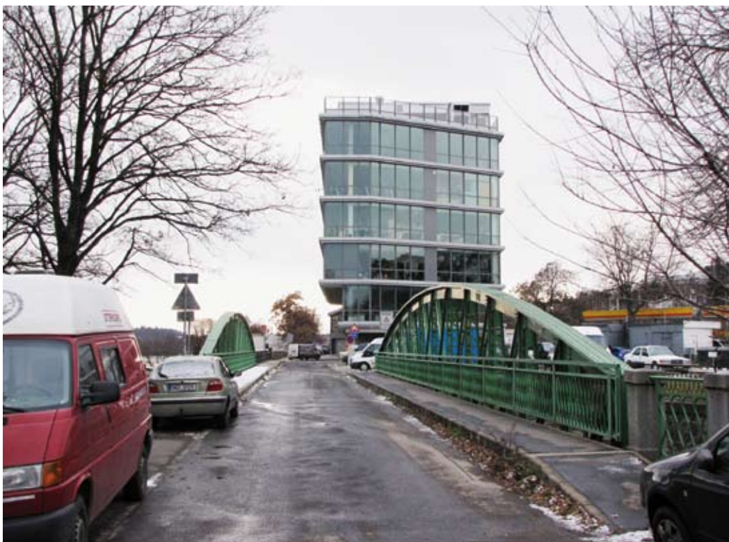
Detailní pohled na železný silniční most a administrativní budovu River Business Centre (Foto: Michal Novotný, 2012)
