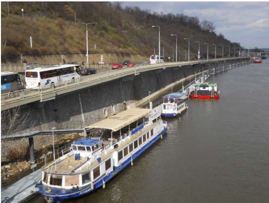
Nábřeží Edvarda Beneše, původně tzv. silnice Pod Letnou, bylo v úseku mezi Čechovým a Štefánikovým mostem vybaveno před několika lety molem pro kotvení lodí. Panují důvodné obavy, že značná kapacita mola byla zamýšlena pro trvalé stavby, tvářící se jako plavidla, které by parazitovaly na blízkosti centra.
